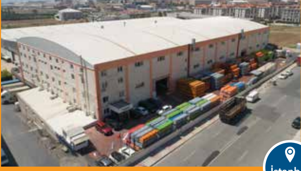
Vana ve PP-R Sistem Üretim Tesisi
