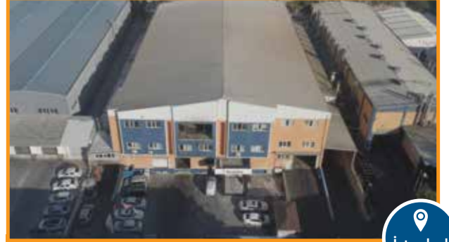
Metal Üretim Tesisi
